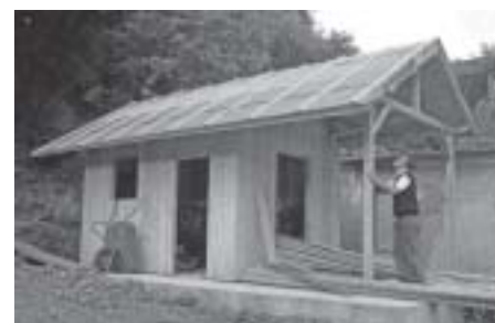
Das neue Garten- und Gerätehaus
