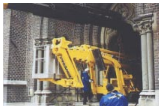
Fünf Tage lang ein Kran in der Kirche
