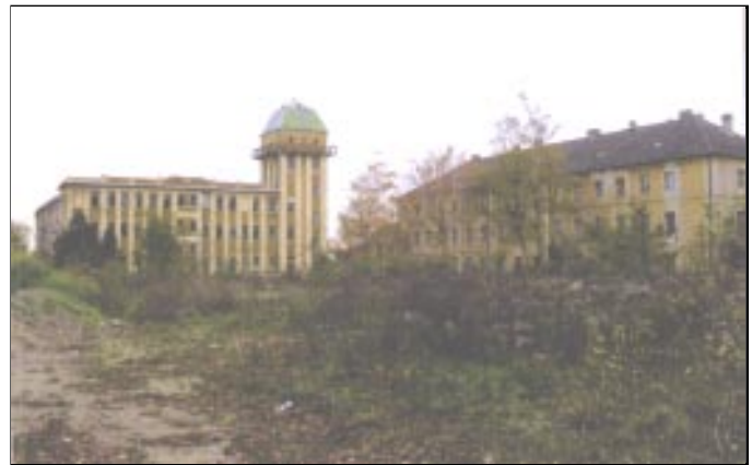
Das Fabriksgebäude der Baumwollspinnerei heute
