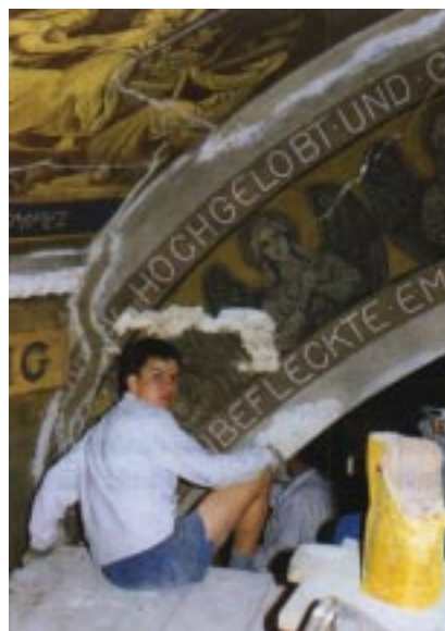
Erste große Innenrenovierung seit 1934
