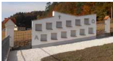
Die neue Urnenwand
