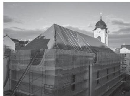
Neben der kompletten Neudeckung des Kirchendaches musste der Dachstuhl an einigen Stellen repariert werden.
